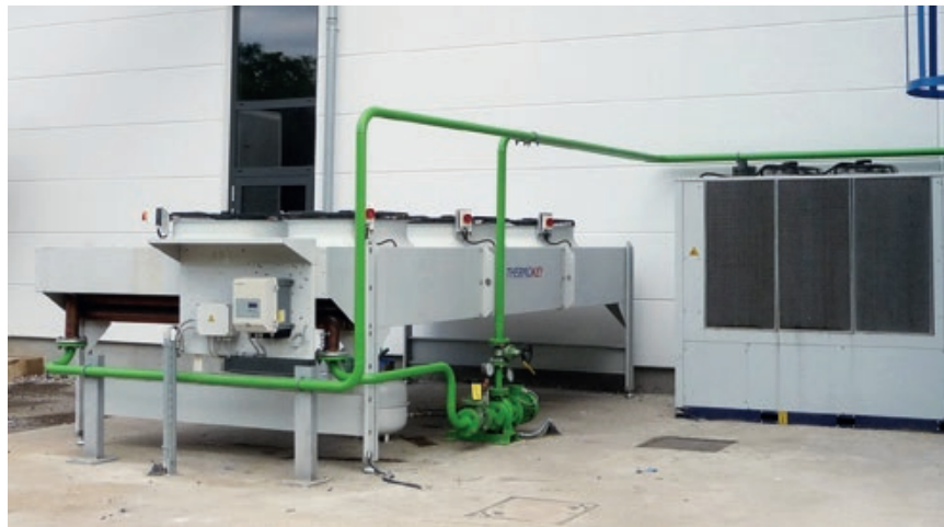
Wasserrückkühlung mit geschlossenen Kreisläufen Water recooling system with closed circuits
