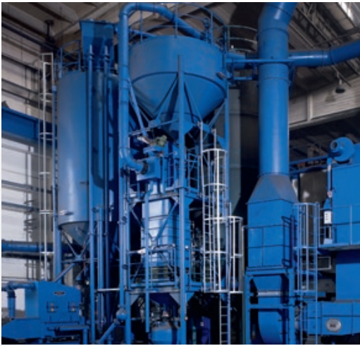
Heißsandsilo und Staukühler Hot sand silo and retaining cooler
