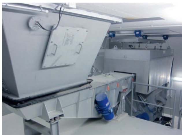
Trichter unter dem Ausschlagrost, Schwingförderrinne, Magnet und Vibrationsknollenbrecher Hopper under the shake out grid, vibratory conveyor trough, solenoid and vibratory lumps breaker
