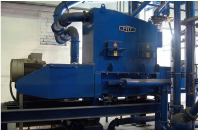
Combicleaner – dynamische Regenerierung zur mechanischen Reinigung des Sandes Combicleaner – dynamic reclamation for mechanical cleaning of the sand
